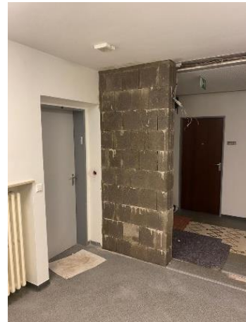
Versetzen der Brandschutztür im 2. Stock
